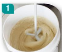
Añada Maxiempaste® Extra Liso Interior al agua limpia. Mezcle por medios mecánicos hasta obtener un mortero cremoso, plástico y homogéneo.
