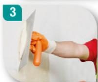
Coloque la siguiente capa. Una vez que esta haya secado coloque la capa final, dando acabado con la llana metálica en sentido horizontal.
