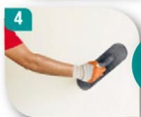
**Recomendación:** Para optimizar el acabado final, utilice una llana metálica lisa de puntas redondas, presionando y realizando movimientos circulares en toda el área.
