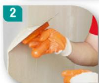
Coloque Maxiempaste® Extra Liso Interior, con llana metálica lisa presionando contra la superficie en sentido vertical. Coloque la segunda capa cuando la anterior haya secado al tacto.
