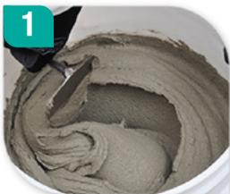
1. Añada mortero al agua limpia. Mezcle hasta obtener un mortero plástico y homogéneo. Déjelo reposar de 5 a 10 minutos. Vuelva a batir antes de usarlo.
