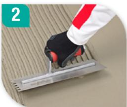
2. Extienda suficiente mortero con la parte lisa de la llaneta y con la parte dentada peine el mortero en una sola dirección.
