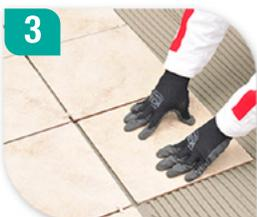
3. Coloque la placa con moderada presión usando un movimiento perpendicular a las estrías del mortero para aplastarlas y obtener una distribución uniforme del mortero.
