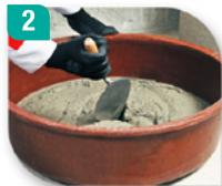
Mezcle hasta obtener un mortero plástico y homogéneo. Vuelva a batir antes de aplicar el mortero.
