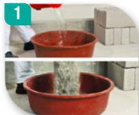
Añada Pegablok® al agua limpia y fresca, acorde a lo indicado en la sección Datos Técnicos de la parte posterior del saco.
