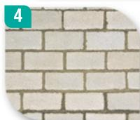
Dé acabado a las juntas cuando el mortero haya endurecido levemente. Proteja de la lluvia y de vibraciones fuertes por 8 horas. Cure las juntas a partir del día después de la instalación por 72 horas.
