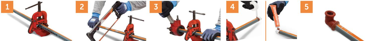
Colocar el tubo a roscar en un tornillo de banco o mordaza sin exagerar el ajuste para evitar ovalamiento, pues esto provocaría una rosca imperfecta. Al realizarlo proteger el tubo de PVC de los dientes del tornillo de banco o mordaza empleando para ello una lija o tela gruesa.
