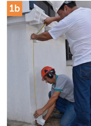
Si los canales están a una distancia determinada del muro o pared (sistema colgante), se instalará un codo de bajante de 45° con el respectivo soporte sobre el muro y otro desde la unión de canal a bajante conectados entre sí por un tramo
