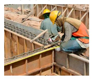
Para encofrados de hormigón, con capa fenólica que permite la reutilización, reduciendo costos.
